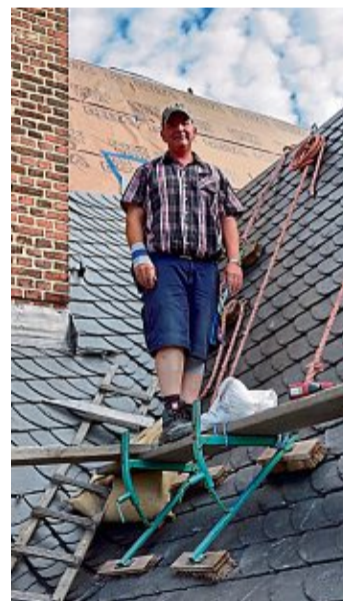
Dachdeckermeister Markus Punstein auf dem Arbeitsgerüst.
